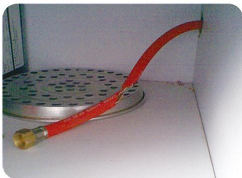
客户在烹饪时，汤汁经常溅到橡胶软管上，致使出现老鼠啃咬而咬断橡胶软管现象，导致燃气泄漏事故的发生。
