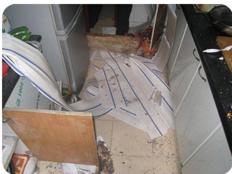
因移动厨房内物品而触碰橡胶管，易引起管卡松动，加之平时不注意观察，而导致橡胶软管脱落，引发燃气泄漏，严重将造成爆炸。
